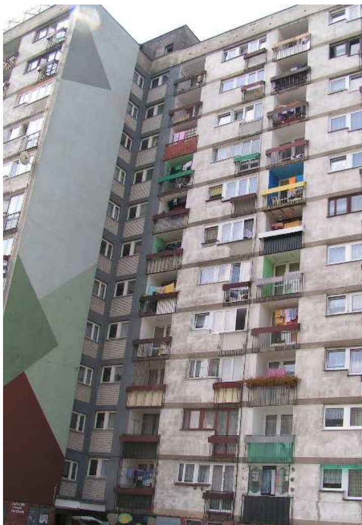
Fot. Blokowiska na osiedlu „M”
