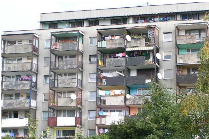
Fot. Blokowiska na osiedlu „U”
