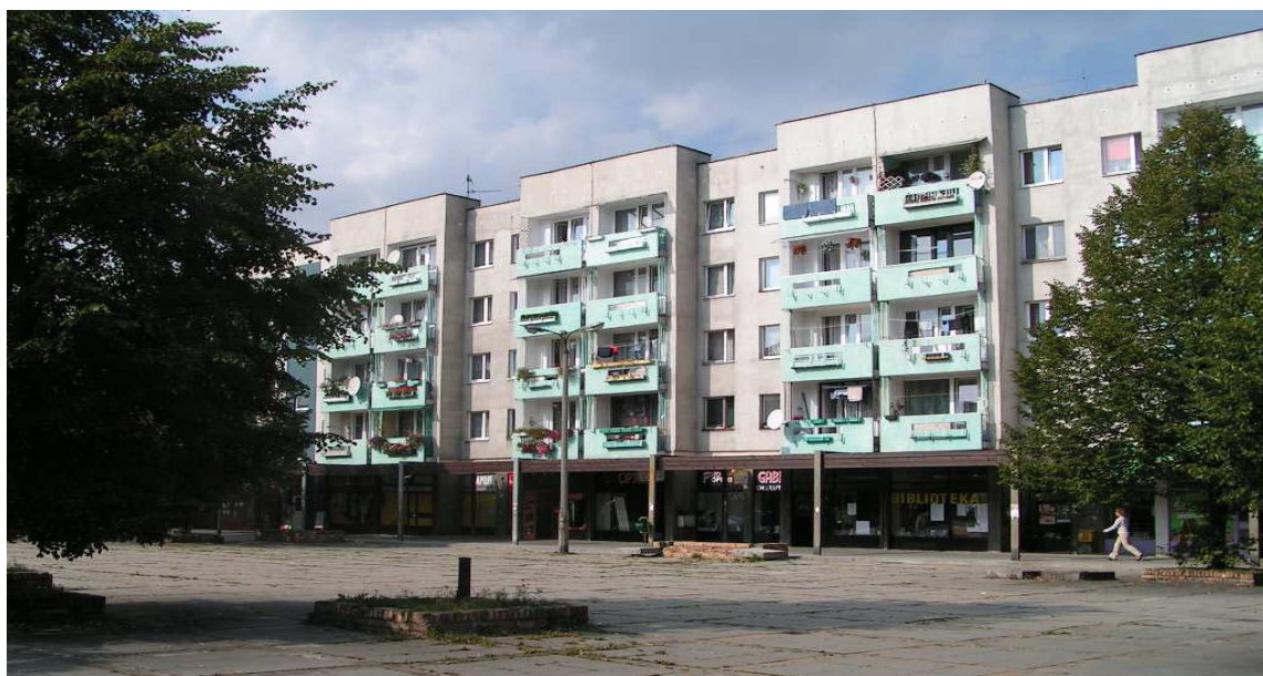
Fot. Plac Korfantego – osiedle „K”, wymagający modernizacji
