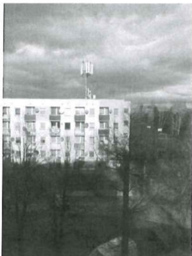
Widok obiektu wraz z zainstalowanym zespołem antenowym
