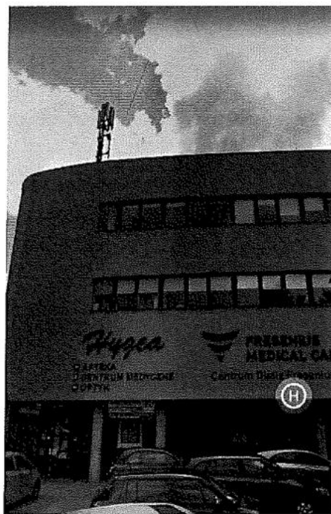
Zal. nr 1: Widok ogólny badanego obiektu.
