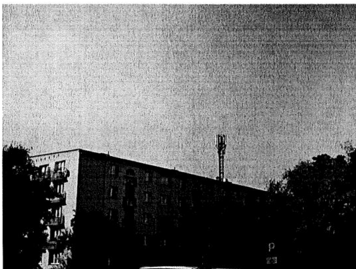
Zał. nr 1: Widok ogólny instalacji radiokomunikacyjnej.
