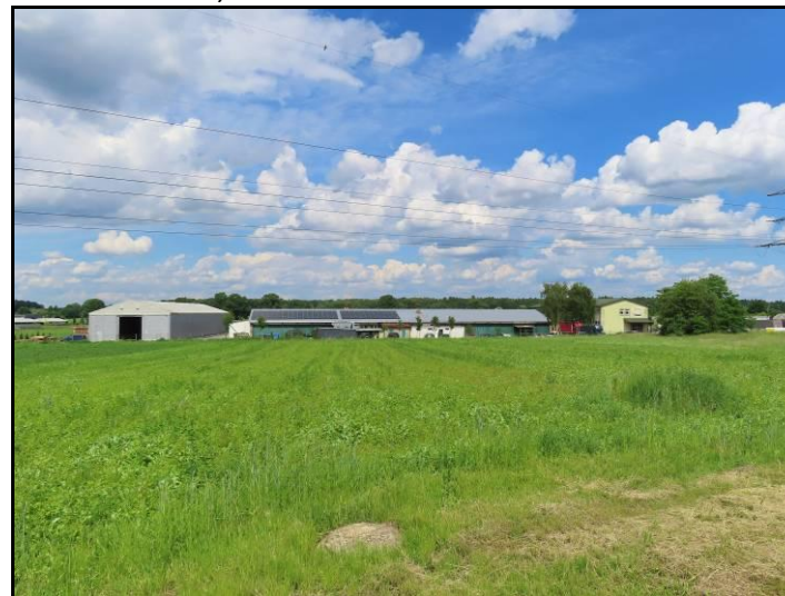
Fot. 12 Obiekty widoczne z ul. Murarskiej
