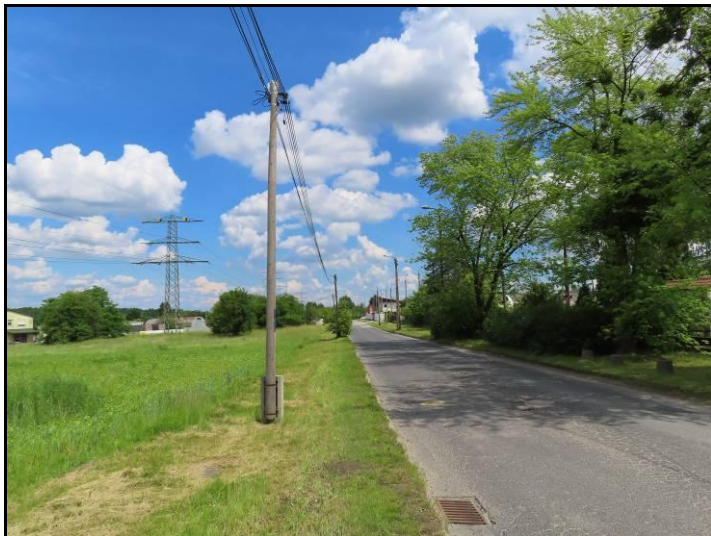
Fot. 13 Ul. Murarska, widok w kierunku wschodnim w części centralnej
