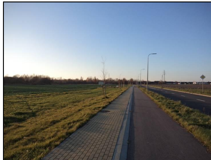
Fot. 11 Ul. Imbirowa, widok w kierunku zachodnim
