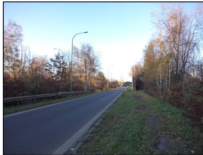
Fot. 7 Droga łącząca DK1 z DK44 w południowo-zachodniej części terenu
