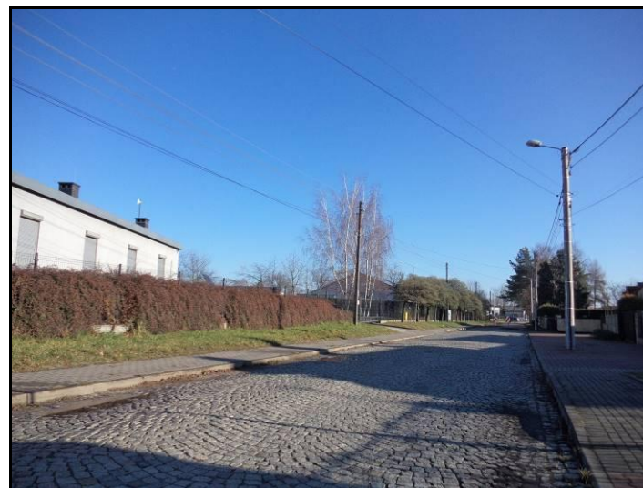
Fot. 7 Ul. Dojazdowa, widok w kierunku południowym
