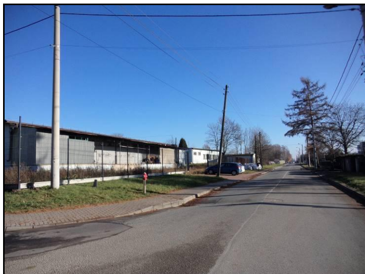
Fot. 9 Ul. Wałowa, widok w kierunku wschodnim
