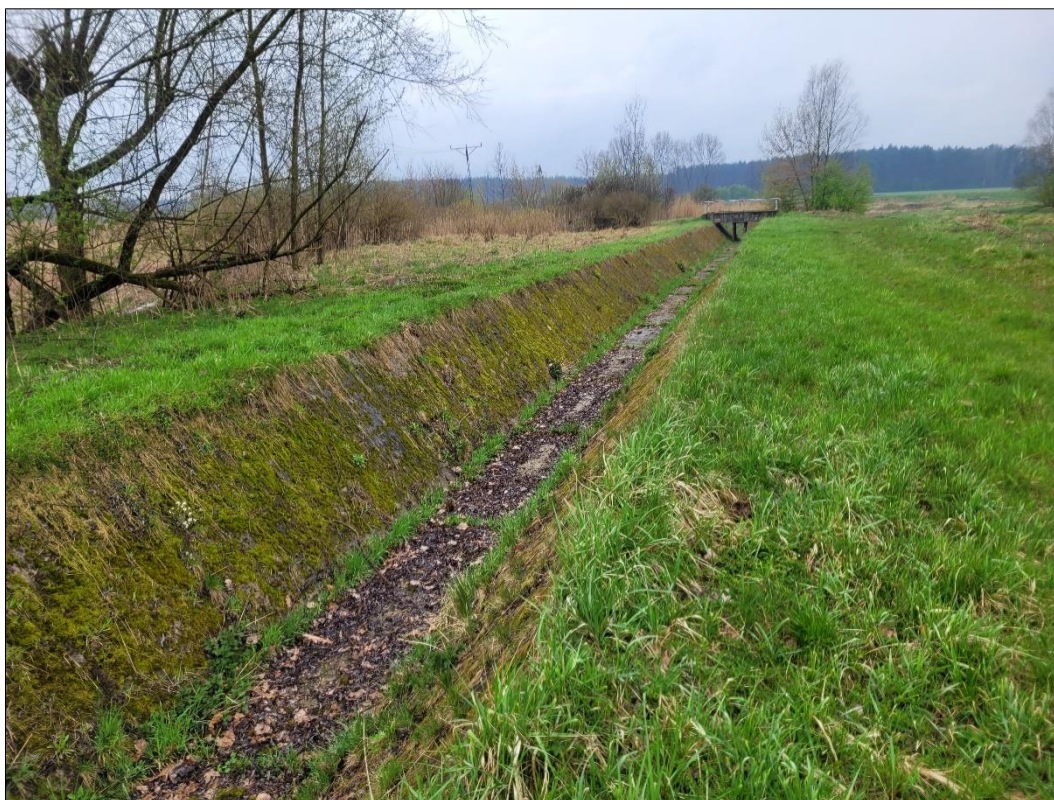
FOTOGRAFIA 2. JEDEN Z KANAŁÓW ŚCIEKOWYCH – SUCHY – WYBETONOWANE KORYTO (MARZEC-KWIECIEŃ 2023 R.)
