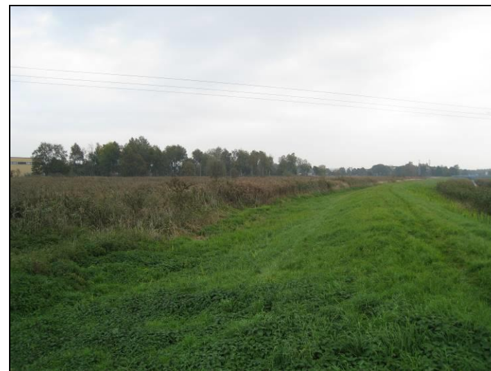
Fot. 31 Widok w kierunku wschodnim
