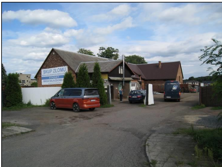
Fot. 1 Analizowany teren od strony zachodniej
