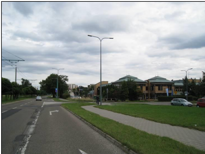
Fot. 1 Budynek w którym mieści się m.in. Dom Kultury, widok od strony Alei Jana Pawła II, od strony zachodniej
