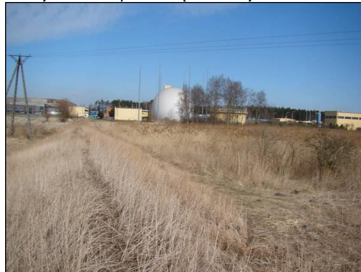
Fot. 8 Oczyszczalnia widziana od strony południowej z doliny Gostyni
