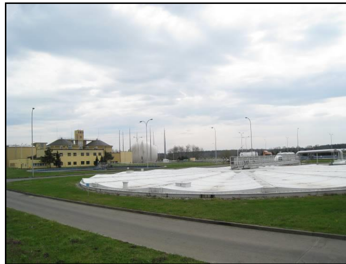
Fot. 3 Widok na centralną część oczyszczalni od strony ul. Lokalnej
