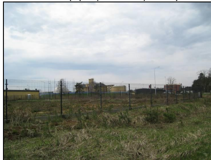
Fot. 4 Zabudowania oczyszczalni w części wschodniej
