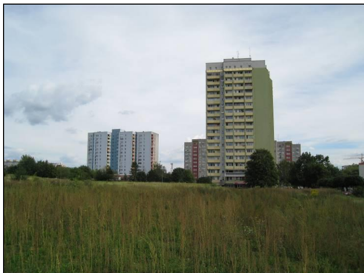
Fot. 13 Widok w kierunku wschodnim
