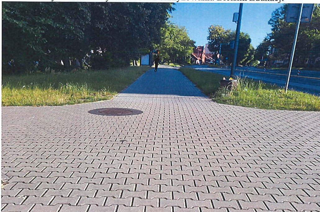
Wyremontowany odcinek od skrzyżowania Bielska/Edukacji
