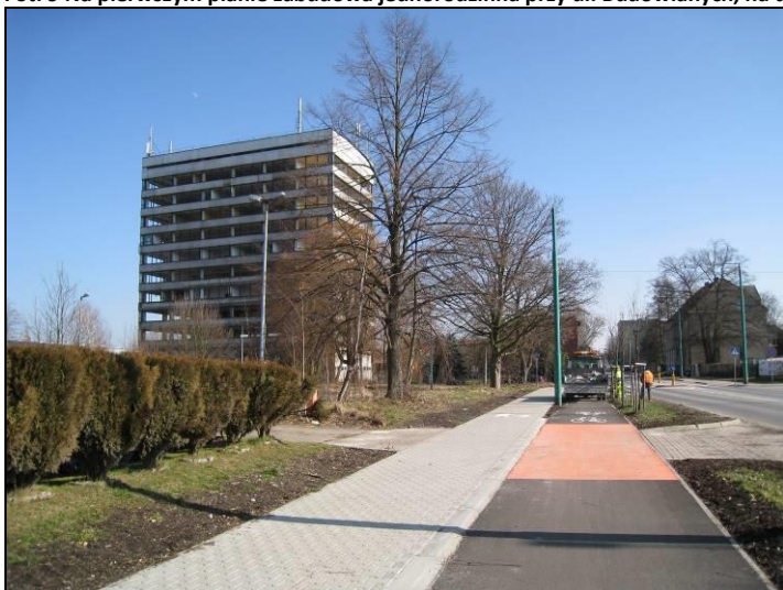
Fot. 10 Opustoszały wieżowiec widziany od strony zachodniej
