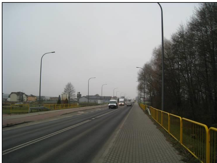
Fot. 9 Ul. Oświęcimska, widok w kierunku zachodnim
