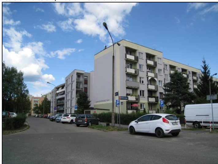
Fot. 6 Zabudowa wielorodzinna przy ul. K. Dunikowskiego
