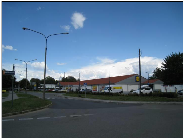
Fot. 9 Zabudowa usługowa przy ul. M. Kopernika
