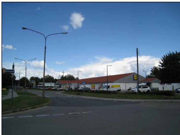
Fot. 9 Zabudowa usługowa przy ul. M. Kopernika
