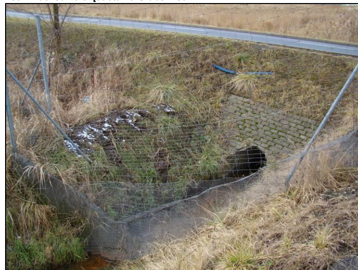
Fot. 8 Wyływ cieków zasilających staw Grabowiec spod nowo powstałej ulicy
