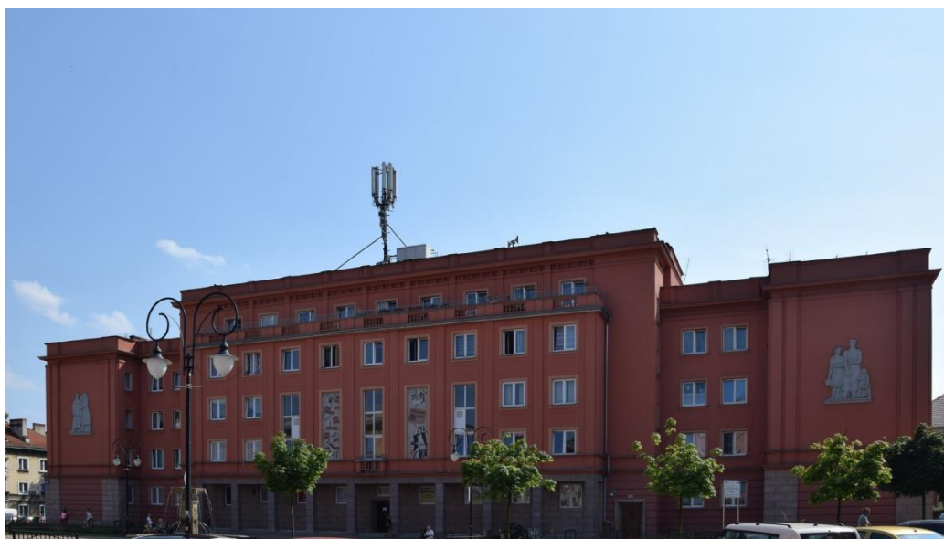
Fotografia 8 Maszt telefonii komórkowej na budynku przy placu Św. Anny (Osiedle A) (fot. M.Rolka)
