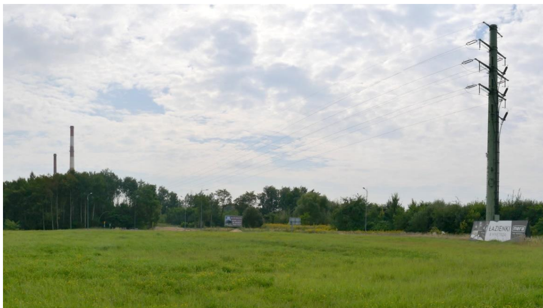
Fotografia 7 Słup kablowy wysokiego napięcia przy węźle drogowym DK1/a1. Niepodległości (fot. M. Rolka)
