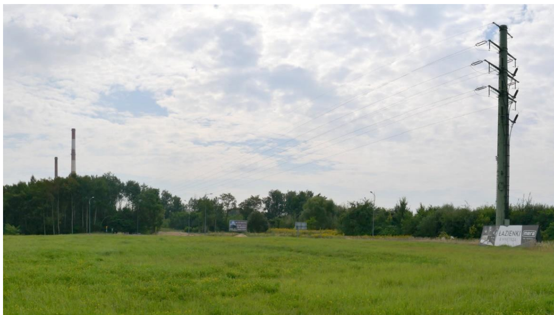
Fotografia 7 Słup kablowy wysokiego napięcia przy węźle drogowym DK1/al. Niepodległości (fot. M. Rolka)
