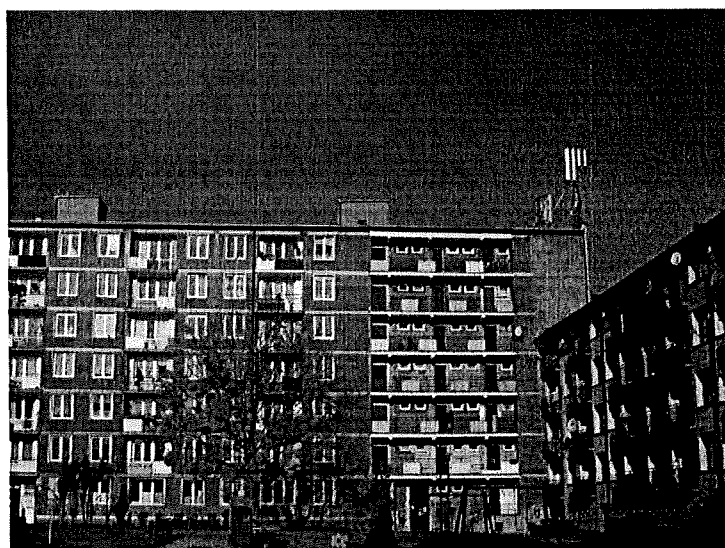
Zał. nr 1: Widok ogólny instalacji radiokomunikacyjnej.
