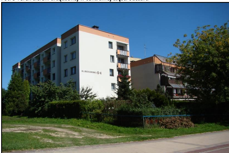
Fot. 6 Zabudowa wielorodzinna w rejonie ul. Orzeszkowej, północna część obszaru
