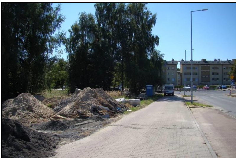
Fot. 1 Zachodnia granica obszaru od strony ul. Uczniowskiej, widok w kierunku południowym
