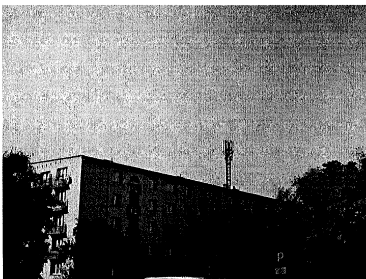
Zał. nr 1: Widok ogólny instalacji radiokomunikacyjnej.
