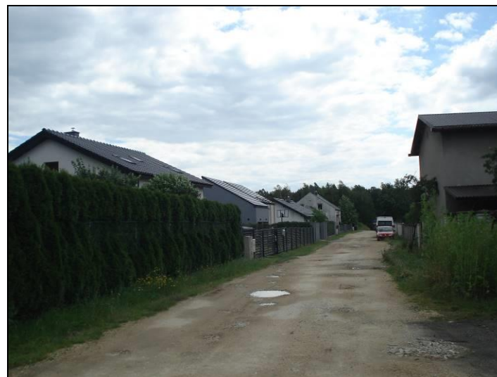
Fot. 11 Zabudowania przy ul. W. Szymborskiej
