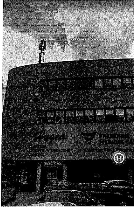
Zal. nr 1: Widok ogólny badanego obiektu.
