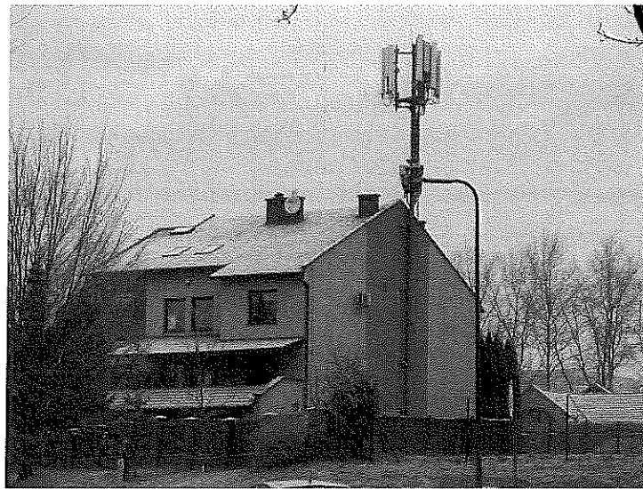
Zal. nr 1: Widok ogólny instalacji radiokomunikacyjnej.
