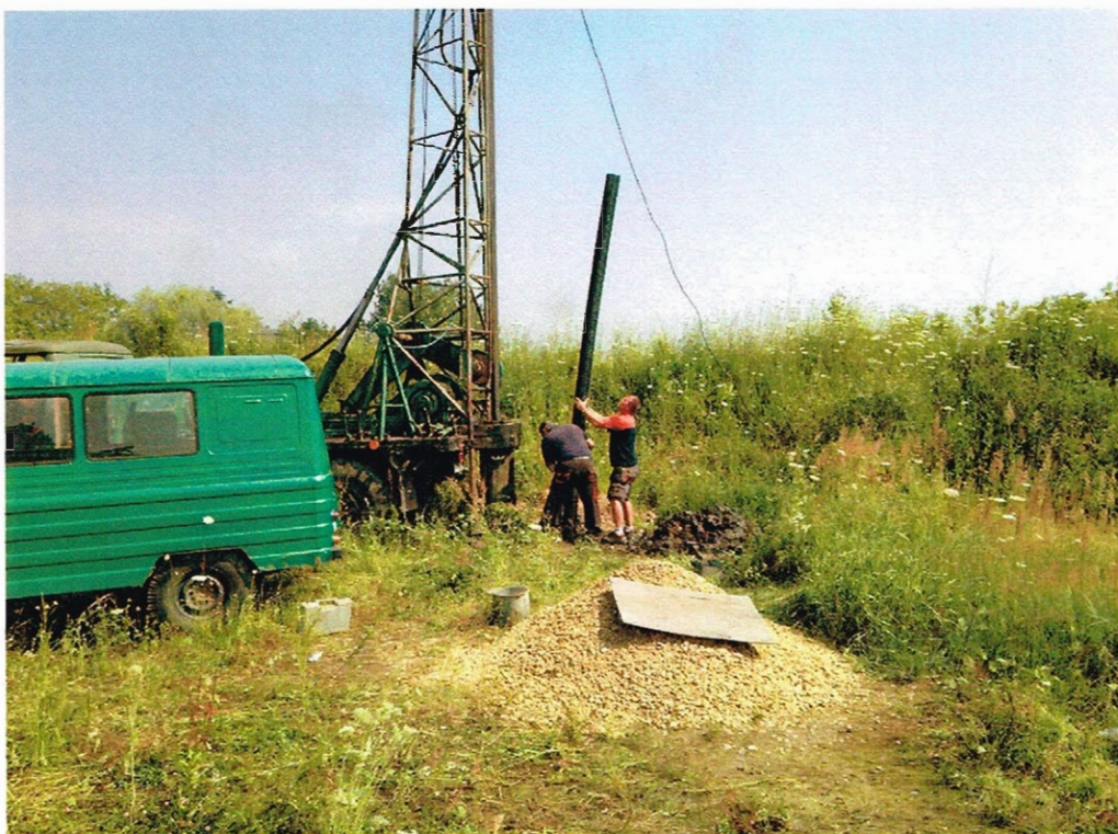
Fotografia nr 5. Wykonanie studni badawczej
