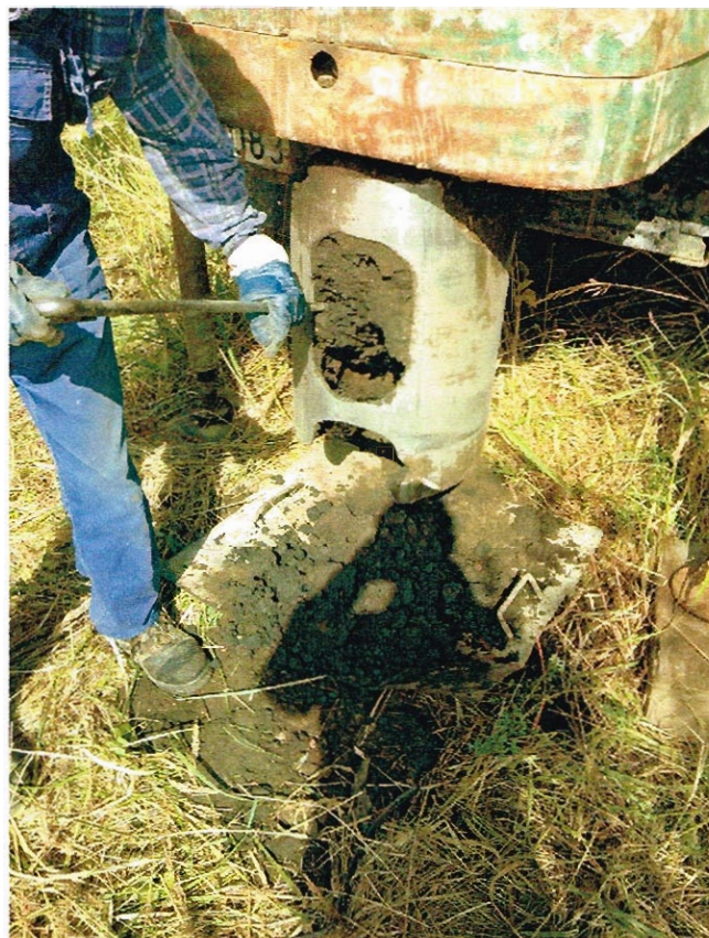
Fotografia nr 10. Wykonanie studni - pobór próbki gruntu
