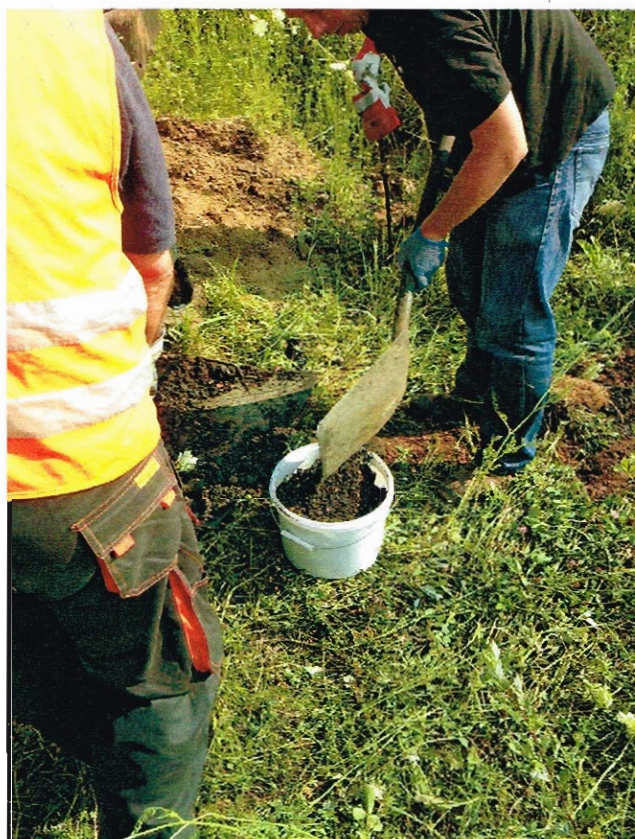
Fotografia nr 8. Pobór próbki gruntu
