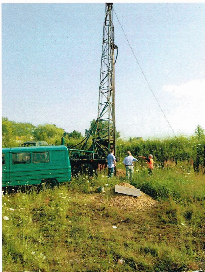
Fotografia nr 6. Wykonanie studni badawczej
