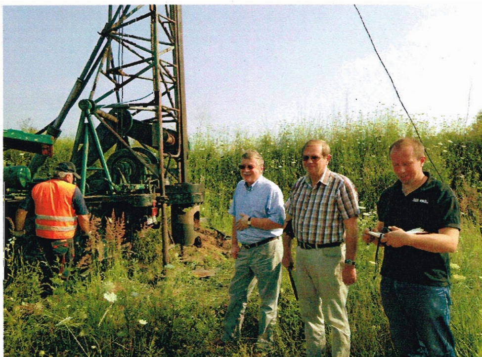
Fotografia nr 4. Wykonanie studni badawczej
