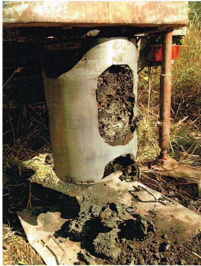
Fotografia nr 11. Wykonanie studni - pobór próbki gruntu
