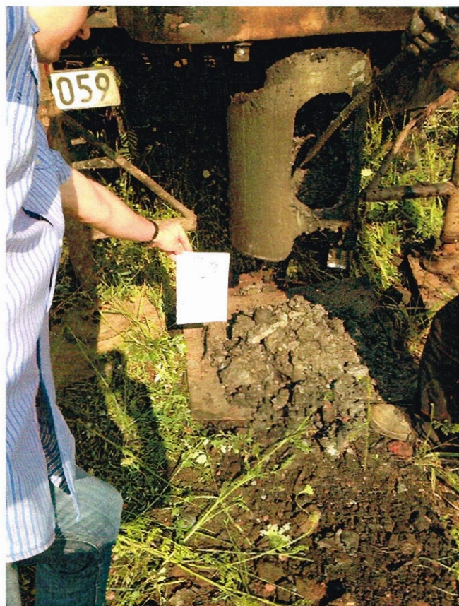
Fotografia nr 9. Wykonanie studni - pobór próbki gruntu
