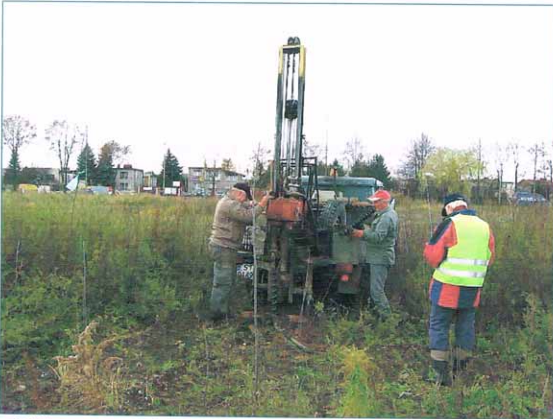
Fot. 3. Wiercenie otworu badawczego na terenie nieruchomości przy ulicy Zwierzynieckiej
