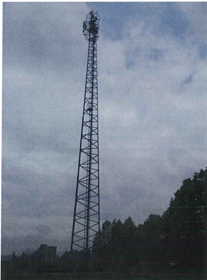
Zdjęcie 1 Badany obiekt
