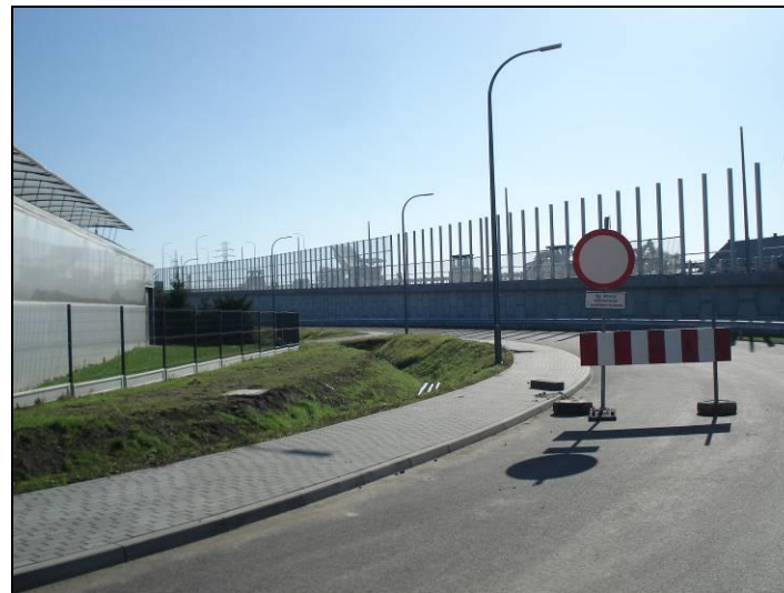
Fot. 3 Rejon przebudowy DK44 w południowej części obszaru
