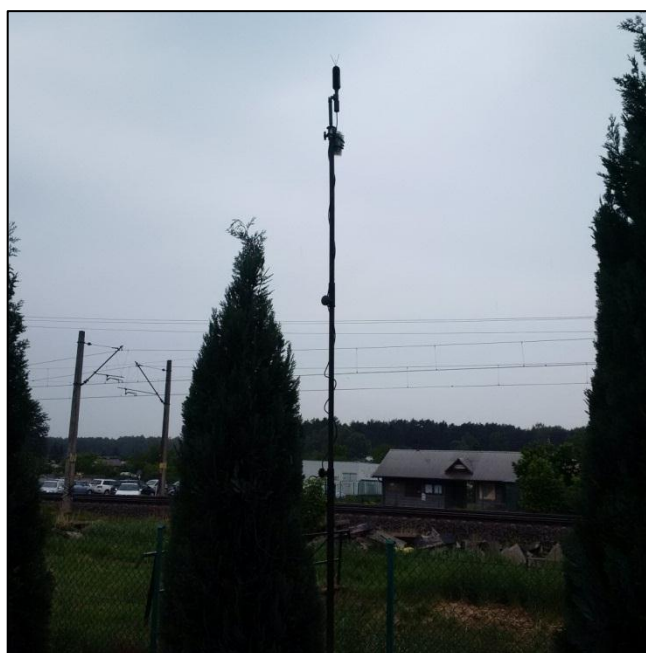
Rys. 6 Widok linii kolejowej nr 139 na wysokości ul. Nizinej.
