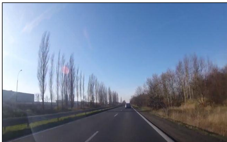
Rys. 4 Widok drogi krajowej nr 44 w rejonie wschodniej granicy miasta Tychy i zakładów FCA Poland S.A.
