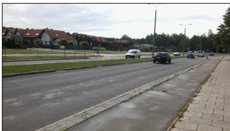
Rys. 8 Widok zabudowy mieszkaniowej jednorodzinnej w rejonie skrzyżowania ul. Sikorskiego z ul. Zbożową.
