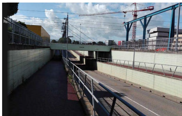
Zdjęcie 13 Niweleta drogi dla rowerów prowadzona powyżej niwelety jezdni. Amsterdamski, Holandia
