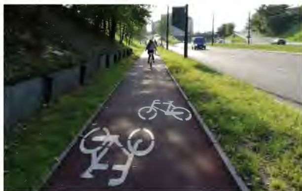
Zdjęcie 15 Droga dla rowerów oddzielona od jezdni pasem zieleni. Sosnowiec, Polska
