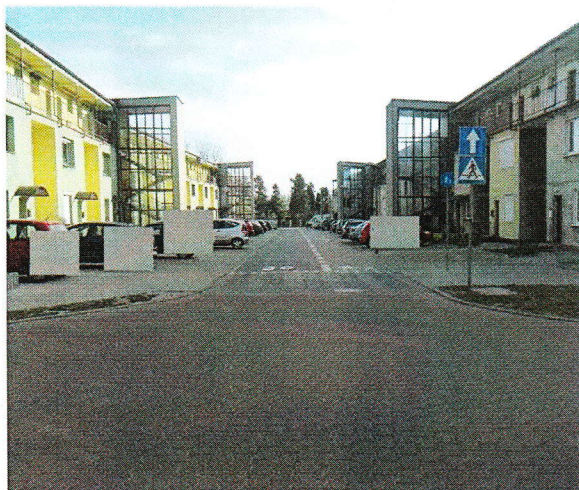
Ulica Einsteina nr 7 i 8 po modernizacji
