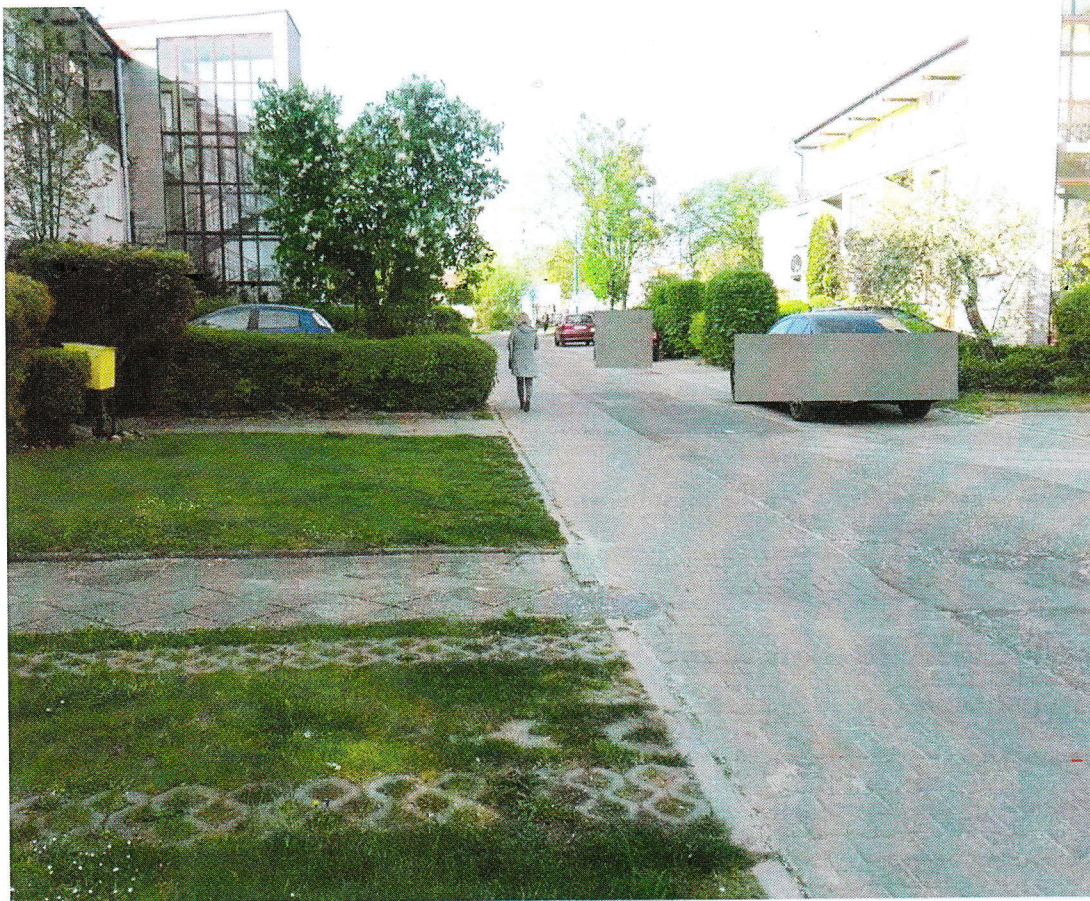
1. Einsteina nr 3 i 4 przed modernizacją
