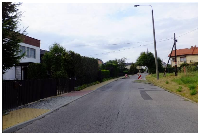
Fot. 7 Ul. H. Jordana
