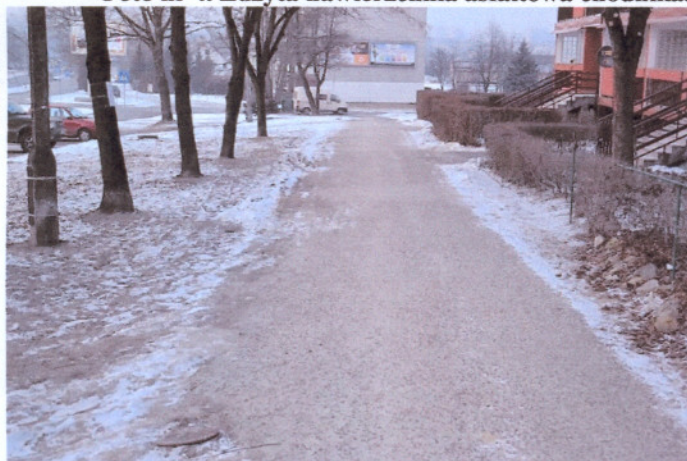
Foto nr 4. Zużyta nawierzchnia asfaltowa chodnika.
