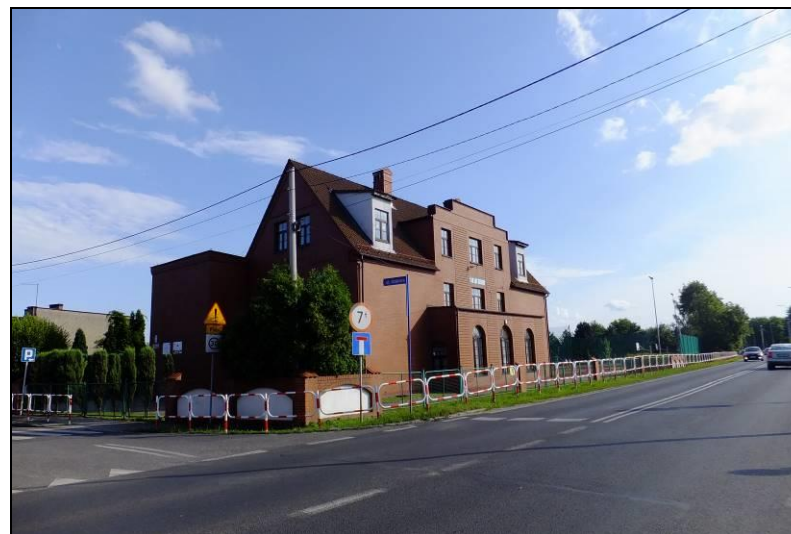
Fot. 15 Budynek zabytkowej szkoły przy ul. Katowickiej
