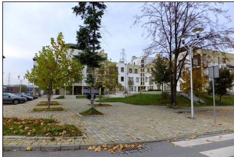
Fot. 3 Widok od strony zachodniej na budynek wielorodzinny, który znajduje się na południe od granic analizowanego terenu
