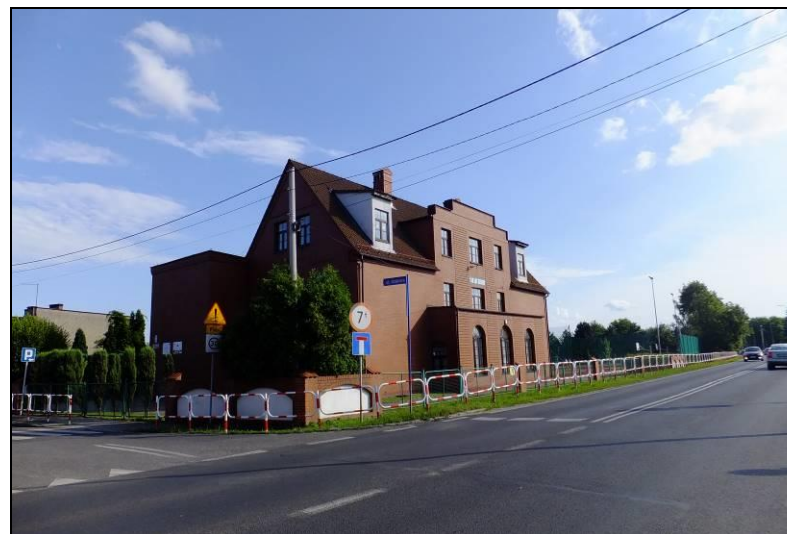
Fot. 15 Budynek zabytkowej szkoły przy ul. Katowickiej
