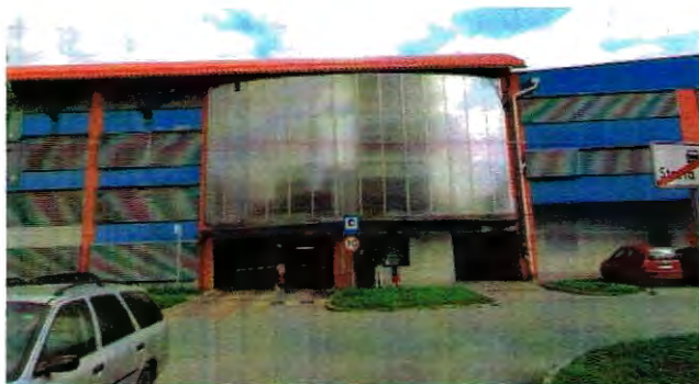
Istniejący teren parkingu - 2KS
