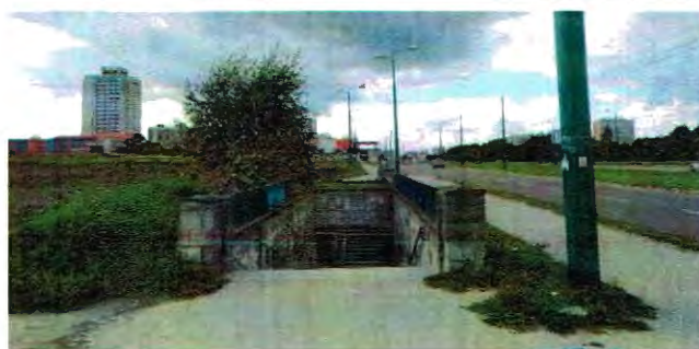
Rejon podziemnego przejścia przy al. Jana Pawła II
