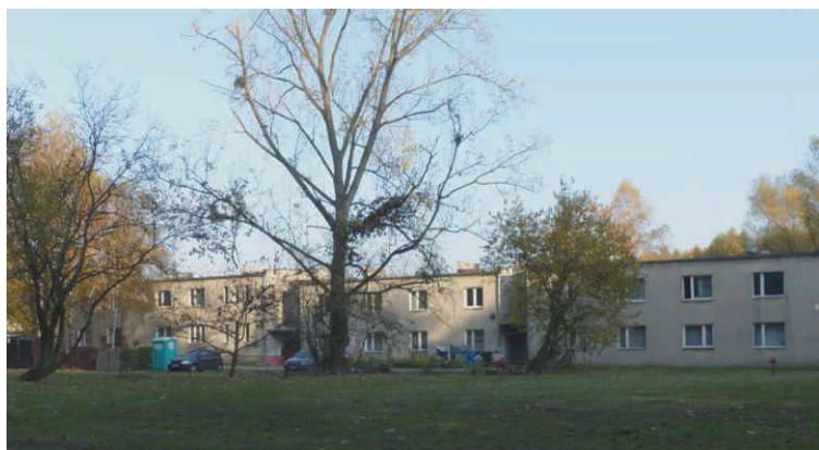
Teren istniejącej zabudowy wielorodzinnej w obszarze planu
