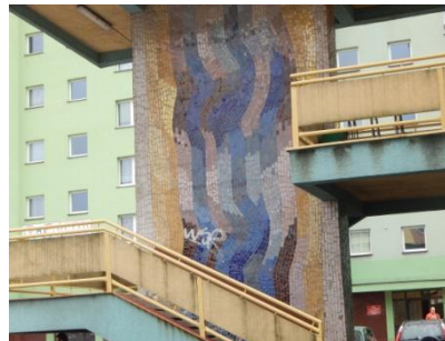
Pylon konstrukcji schodów pawilonu na oś. G przy ul. Kardynała Stefana Wyszyńskiego
