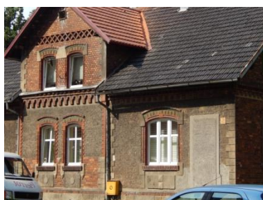
Budynek przy ul. Batorego 5
