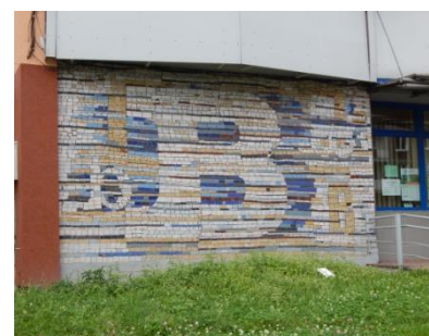
Budynek wielorodzinny z filią Biblioteki Miejskiej przy ul. Dąbrowskiego
