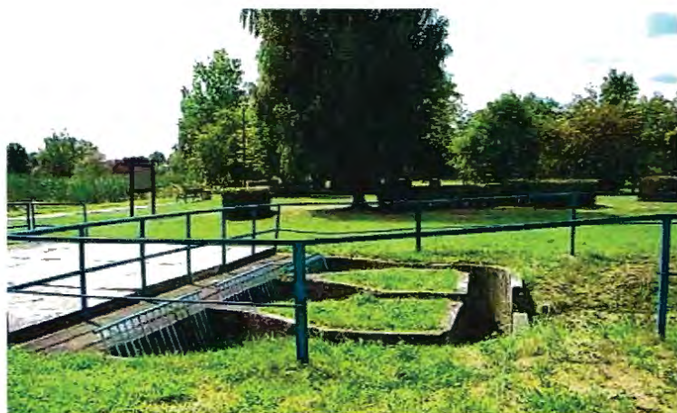
Urządzenia hydrotechniczne znajdujące się w parku związane z wodami powierzchniowymi. Widoczne kratownice na wlocie wody do stawu WS2
