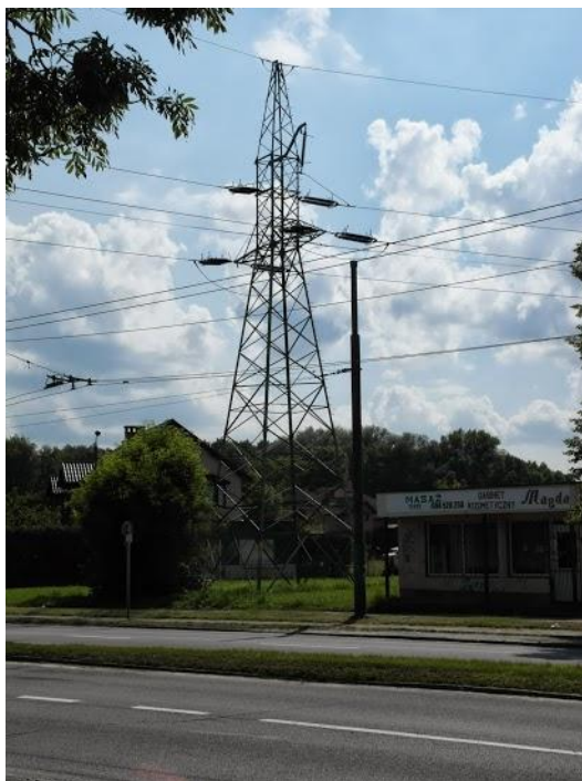
Fotografia 5 Słup WN na osiedlu W
