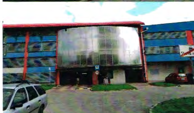
Istniejący teren parkingu - 2KS
