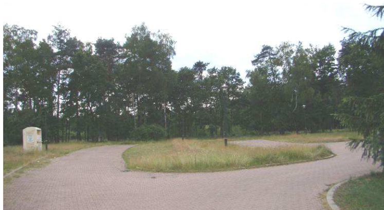
Tereny zieleni oraz droga przy kościele - widok na teren 1KS
