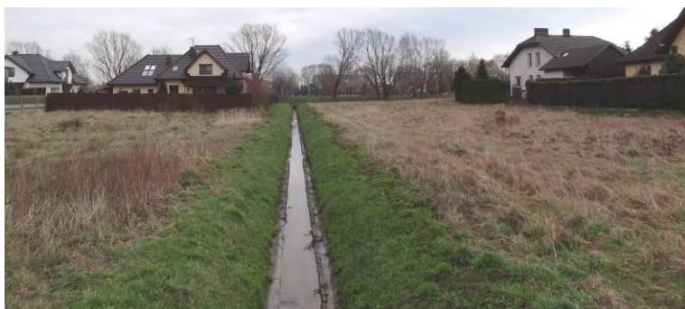
Widok na rów melioracyjny (Potok Żakowski - teren 13WS) z ul. Borowej oraz teren zieleni jako powiązanie ciągu pieszego (12ZP). Widoczna obudowa techniczna koryta ciek.
