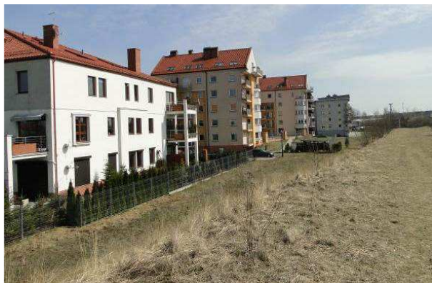
Istniejąca zabudowa oraz nieużytki zielone w rejonie ulicy Barona, w sąsiedztwie linii kolejowej.
