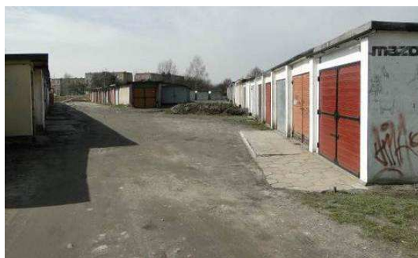
W granicach obszaru znajdują się również garaże – element szczególnie negatywnie wpisujący się w lokalne uwarunkowanie estetyczne terenu.
