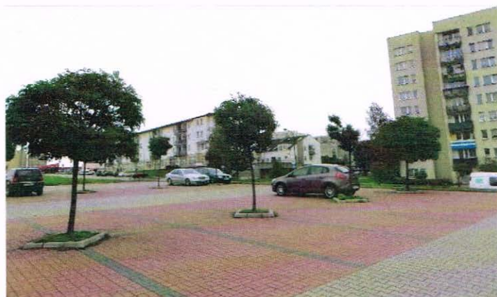
Widok na parkingi po stronie wschodniej 1U przy ul. Księdza Tischnera
